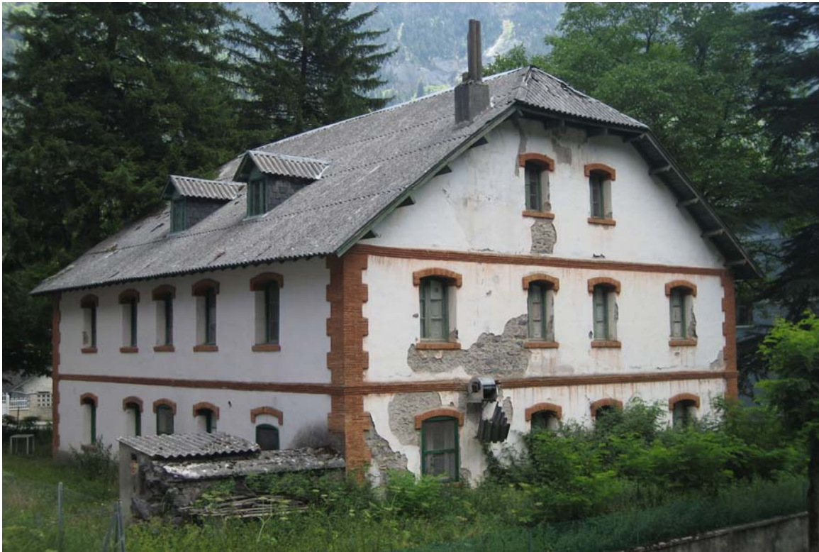
Figura 6. Vista actual del edificio Hotel Internacional en Canfranc.
