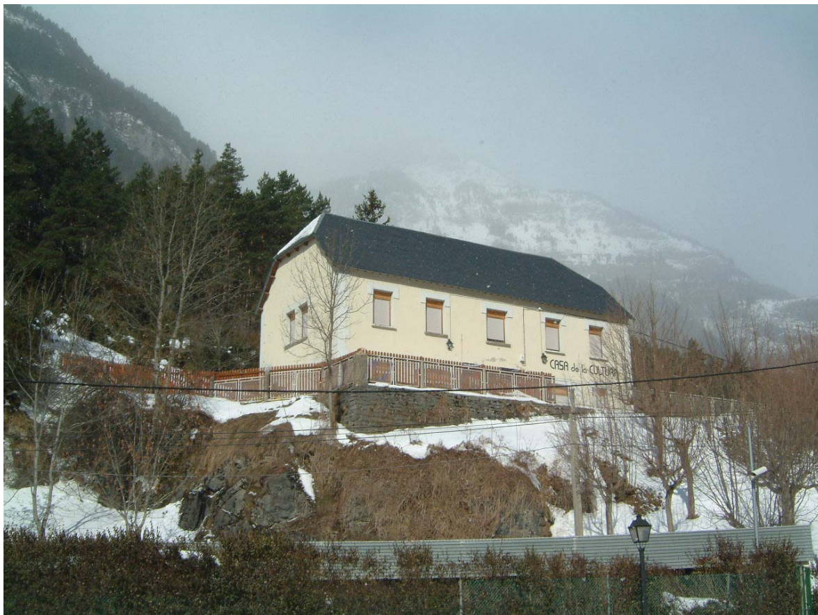
Figura 7. Vista actual del edificio Casa de la Cultura.
